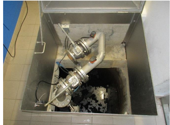
Figure 10 : Puits du Moulin
