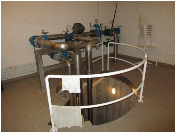
Figure 6 : Escalier d'accès au Puits des Baumes
