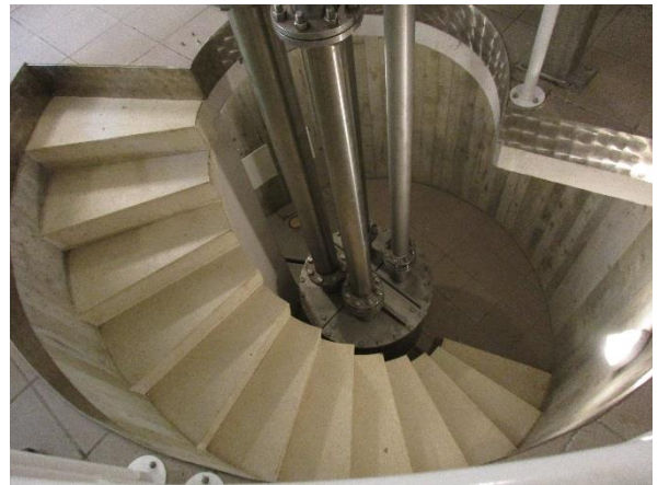
Figure 7 : Escalier d'accès au Puits des Baumes
