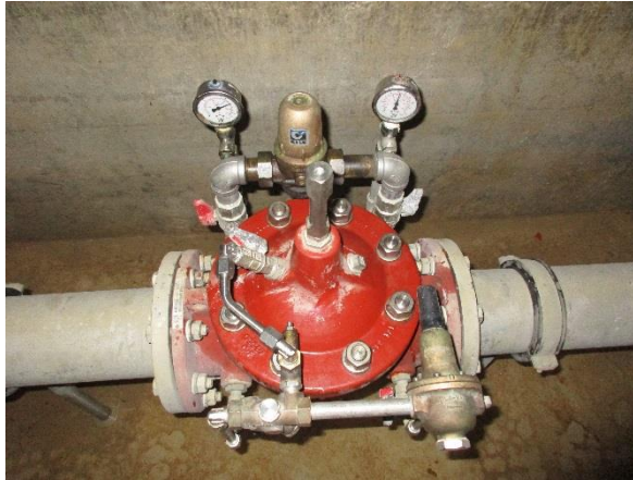
Figure 21 : Réducteur de pression de Corsallettes
