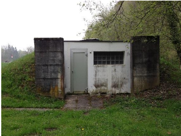
Figure 9 : Puits du Moulin
